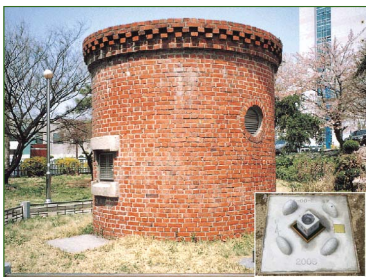
Рис. 4 Исходный пункт отсчета высот в техническом колледже Инха и типовой пункт нивелирования [5]
